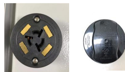
II.A.2.1.2 - Tomada do relé fotoelétrico
