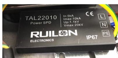
II.A.10 - Dispositivo de Proteção Contra Surtos de Tensão (DPS)
